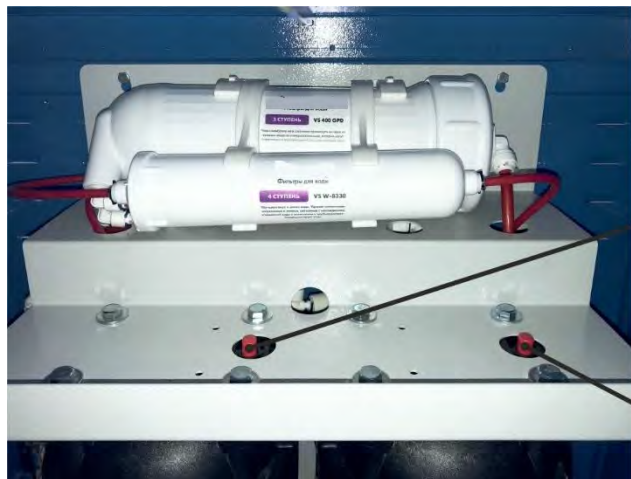
Рисунок 25 – кнопка сброса давления на кронштейне системы обратного осмоса
