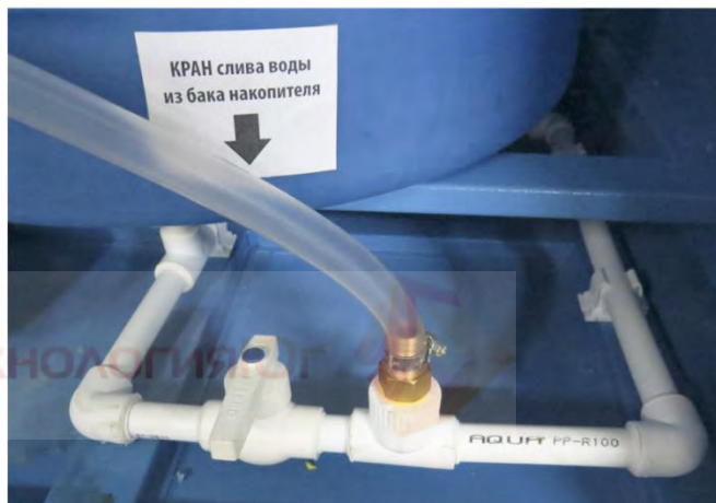
Рисунок 24 – А - кран подачи сетевой воды, В - кран слива воды из бака накопителя
