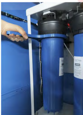
Рисунок 25 – кнопка сброса давления на кронштейне системы обратного осмоса
